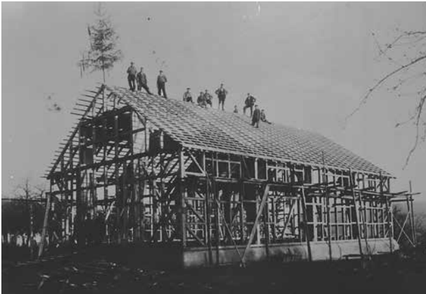
Richtfest der alten Turnhalle in Gomaringen, Lindenstraße
